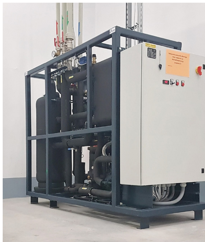
Dwufunkcyjny transkrytyczny agregat chłodniczy / pompa ciepła CO 2
